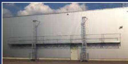
Sie setzen die Rahmen der Brücke auf dem Boden aneinander; das Aufziehen der Brücke wird dann mit Hilfe von Handwinden erledigt.
