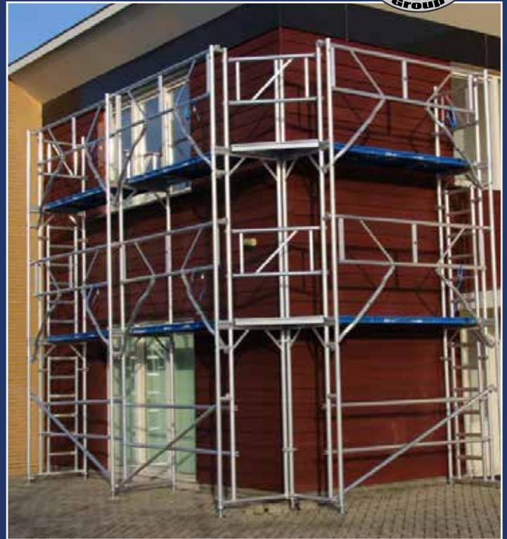
Ein weiterer Vorteil dieses Gerüstes ist, dass Sie die Aluminiumrahmen von unten nach oben (über Kopf) aufbauen können, so dass bereits beim Aufbau auf jeder Ebene die Absturzsicherheit gewährleistet ist.
