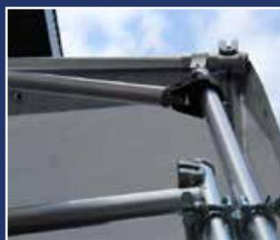
Durch die flexiblen Einstellungen der Teleskop-Gelenkstücke kann das Gerüstdach so stark gespannt werden, als dass ein Flattern des Daches auf ein Minimum beschränkt wird.
